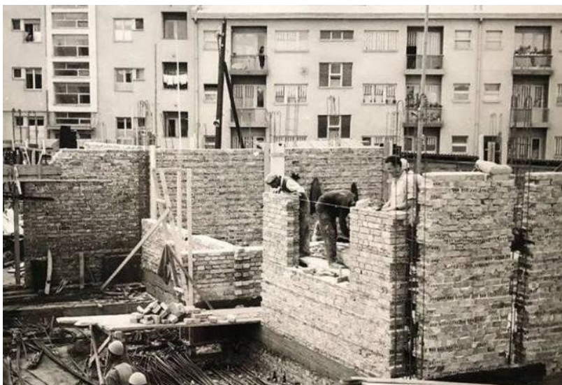
Foto 2. Ndërtimi i ndërtesave me sistem muraturë të përforcuar me shirita nga betoni i armuar
