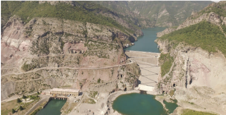
Fig. 188. Liqeni dhe diga e Hidrocentralit të Komanit
