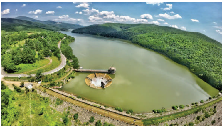
Fig. 183. Batllava-Diga dhe liqeni
