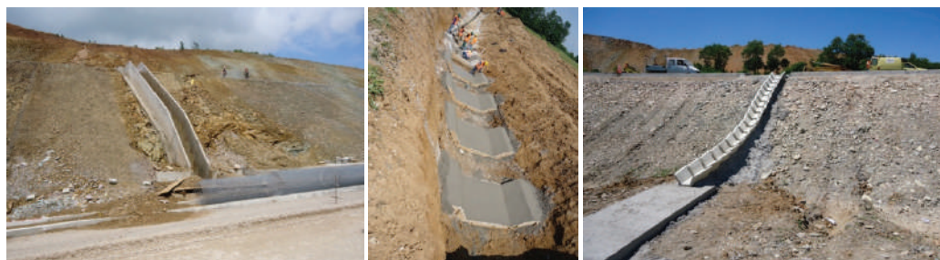
Fig. 257. Rregullimi i kanaleve të jashtme për largimin e ujërave [Foto-Autoret]
