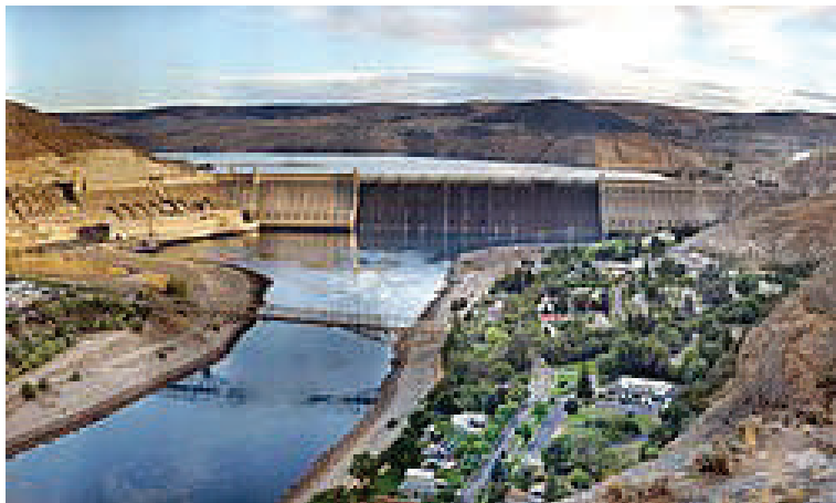
Fig. 313. Hidrocentralet: Grand Coulee
