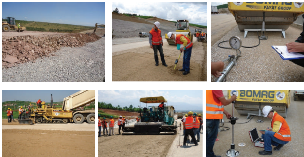
Fig. 251. Procesi i mbushjes dhe kompaktësimi
