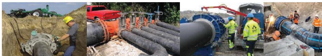
Fig. 172. Instalime të rrjetit të ujësjellësit nga gypat prej polietileni
