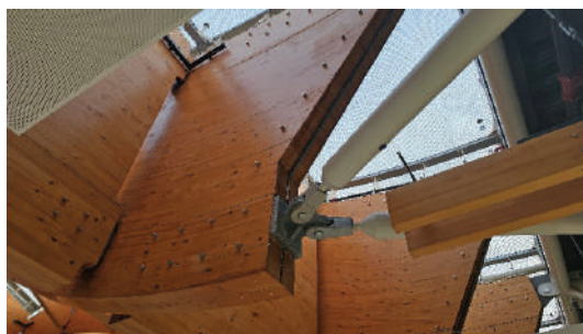
Fig. 204. Lidhje e elementeve strukturore në një nyje
