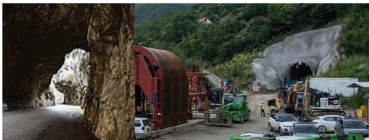
Fig. 305. Tuneli rrugor në Rugovë
