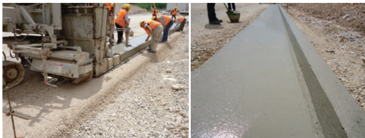
Fig. 258. Betonimi i rigolave
