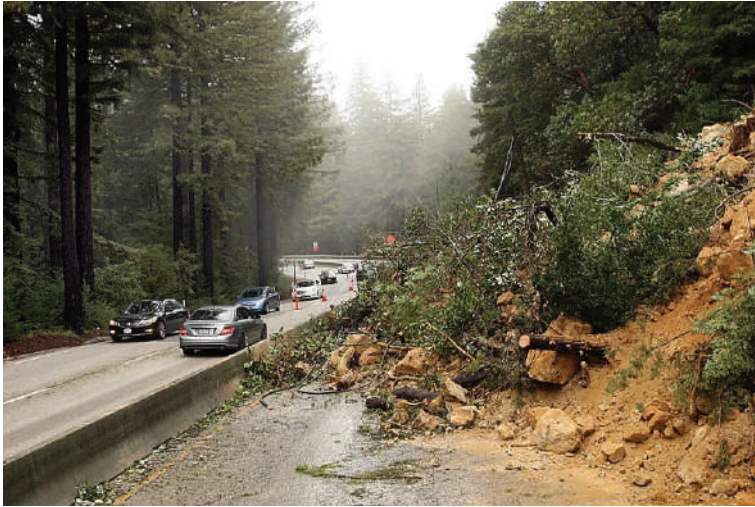
Fig. 299. Erozioni buzë rrugës
