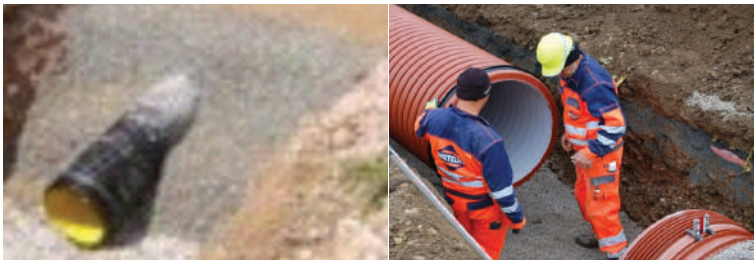
Fig. 178. Mbështjellja e gypave në tërë perimetrin e tyre me ranë për arsye të shtypjes së njëtrajtshme në gyp.
