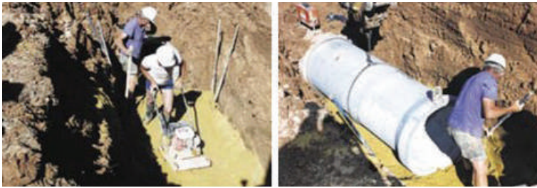
Fig. 177. Shtresa e ranës si bazament për gypat
