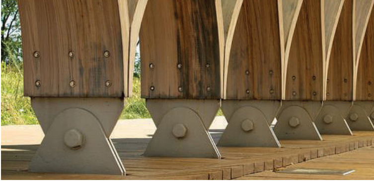
Fig. 83. harniera e realizuar në teren
