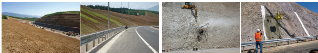
Fig. 252. Humusimi, gjelbërimi dhe përforcimi i skarpatës
