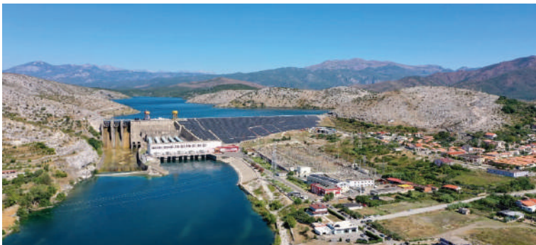
Fig. 189. Liqeni dhe diga e Hidrocentralit të Vaut të Dejës
