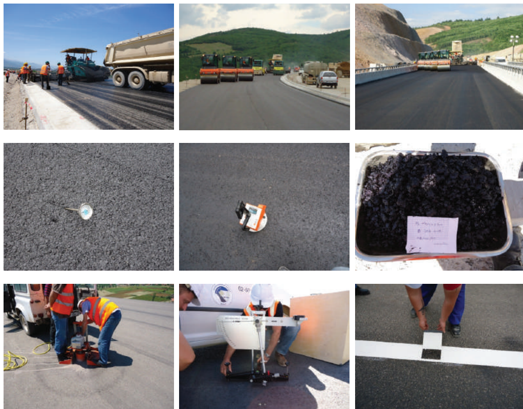
Fig. 261. Procesi i asfaltimit dhe kontrolli i kualitetit në terren
