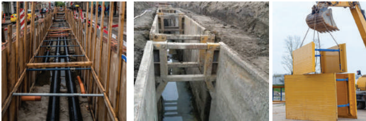
Fig. 180. Sigurimi i kanalit gjatë montimit të gypave
